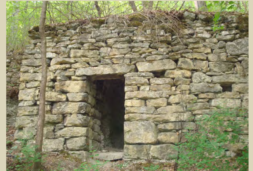
Ein Weinbergshaus im Jenaer Metztal. Wände und Dach bestehen aus Jenaer Muschelkalkstein.
