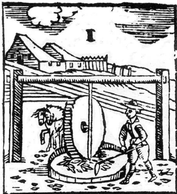
Abb. 3.4-3: Waidmühle mit senkrecht stehendem Läuferstein, Tenne und seitlichen Langsteinen, die das Holzwerk tragen. In der Waidmühle wurden die Blätter zu einem Brei (Waidmus) zerquetscht (Holzschnitt aus dem Zyklus "Abriß etlicher Arbeiten, so im Weyd geschehen müssen" von L. NISKA, Erfurt 1631; aus: SCHREBER 1752, Forschungs- und Landesbibliothek Gotha).
