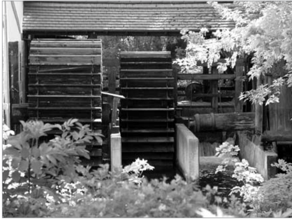
Abb. 3.8-1: Heiligen Mühle Erfurt, 1291 als Mahlmühle urkundlich erwähnt. Die Wasserkraft der Schmalen Gera treibt zwei unterschlächtige Wasserräder (Foto: H.-H. Meyer 2007).
