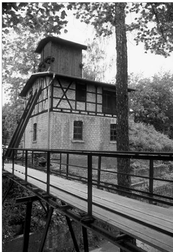
Abb. 3.9-17: Schachtgebäude des Ersatzschachtes von 1904 in Kamsdorf (Foto: G.-R. Riedel 2006).
