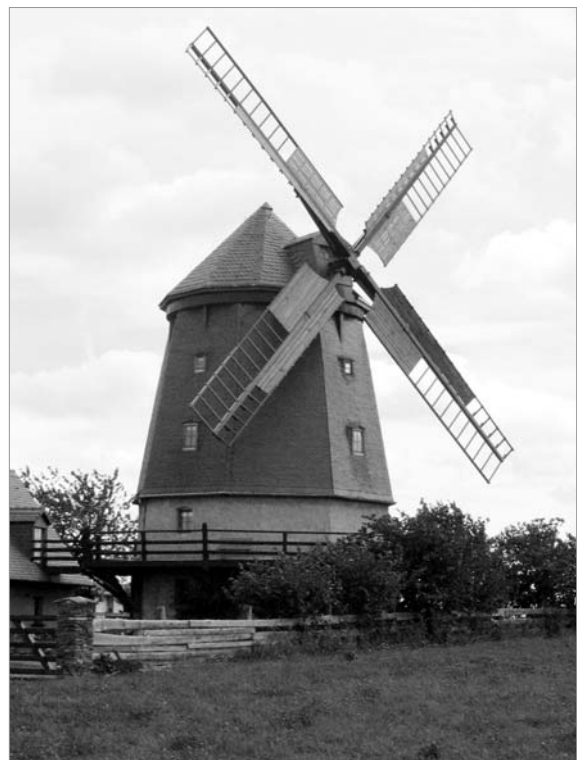
Abb. 3.8-14: Holländermühle in Linda. Galerieholländer, erbaut 1867, bis 1965 in Betrieb, seit 1993 technisches Schauobjekt, komplett erhaltene Mühlentechnik (Foto: C. Glink 2004).
