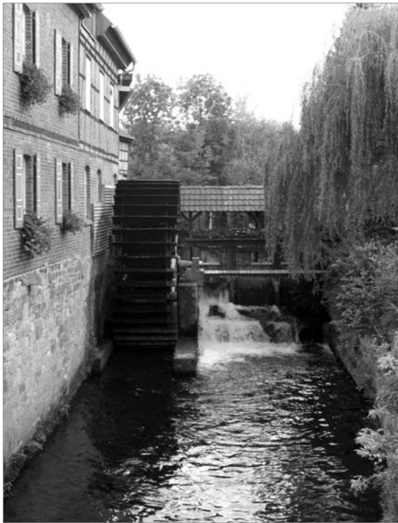
Abb. 3.8-12: Unterühle Freienorla. 1176 erstmals erwähnt, nach 1895 neu errichtet. Bis 1978 trieb die Orla über ein unterschlächtiges Zuppinger-Wasserrad eine Mahlmühle an; heute nutzt man die Technik zur Elektroenergiegewinnung. Die Vermahlungstechnik mit Wasserradantrieb ist vorführbar (Foto: Chr. Glink 2004).
