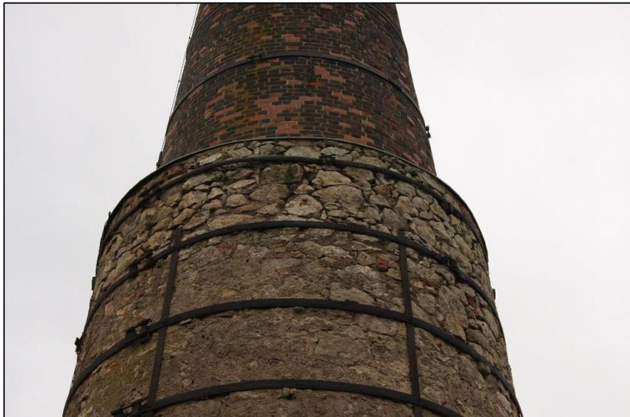
**Abbildung 15 - Eisernes Gerüst des Kalkofens**
