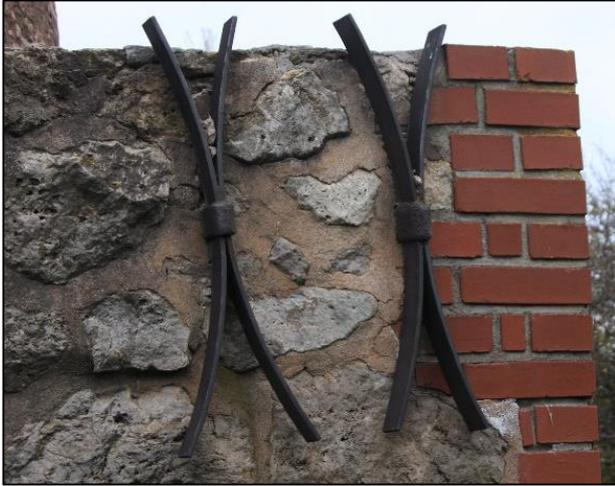
Abbildung 9 - Stabilisierende Maueranker am Sockel mit Erneuerungen mit Ziegelsteinen an Ecken
