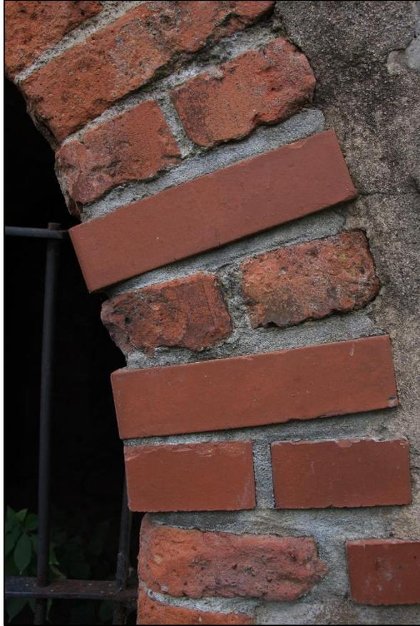
**Abbildung 14 - Erneuerungen der Ziegel beim Eingang zum Sockel**
