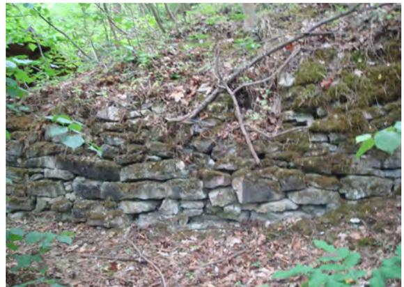
Abb. 65 Die Trockenmauern befinden sich in einem desolaten Zustand. Moos, Erde und Laub bedecken Boden und Mauern. Der Wurzelndruck der Gehölze gefährdet die Stabilität. (Foto: Höpflinger am 08.06.2015)
