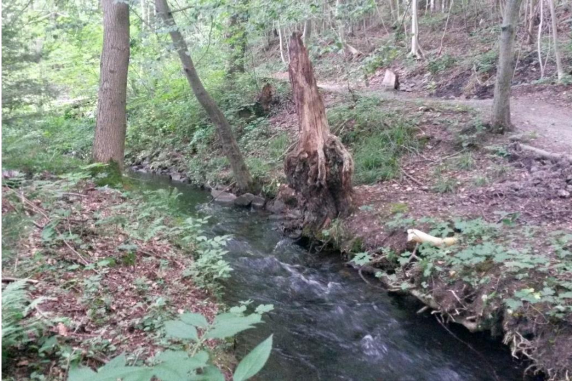
Abbildung 2: Schlecht erhaltener Abschnitt des Flößgrabens bei Georgenthal mit hineinwachsenden Bäumen und unterspülten Ufer. (Bild: Paschke T.)
