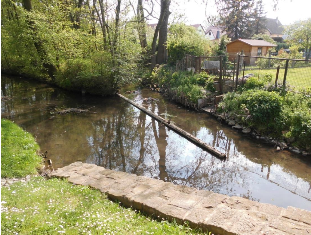
Fotodoku. 9: Zusammenfluss von Flößgraben und Kleinem Leinakanal in Emleben
