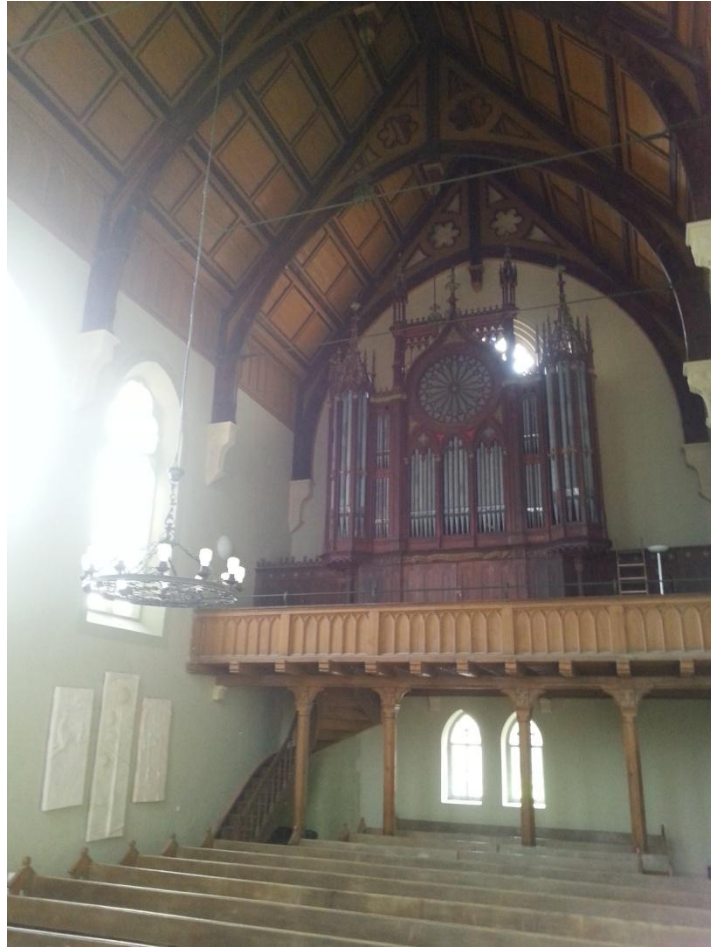
Abb. 24: Detail: Orgelempore und hohe Kasettendecke
