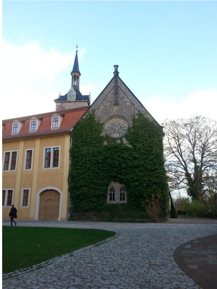
Abb. 9: Außenansicht; von West
