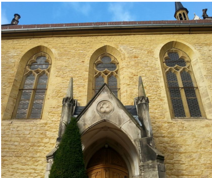
Abb. 7: Detail: Fassade mit Fensterfront und Eingangsportal ; von Südwest
