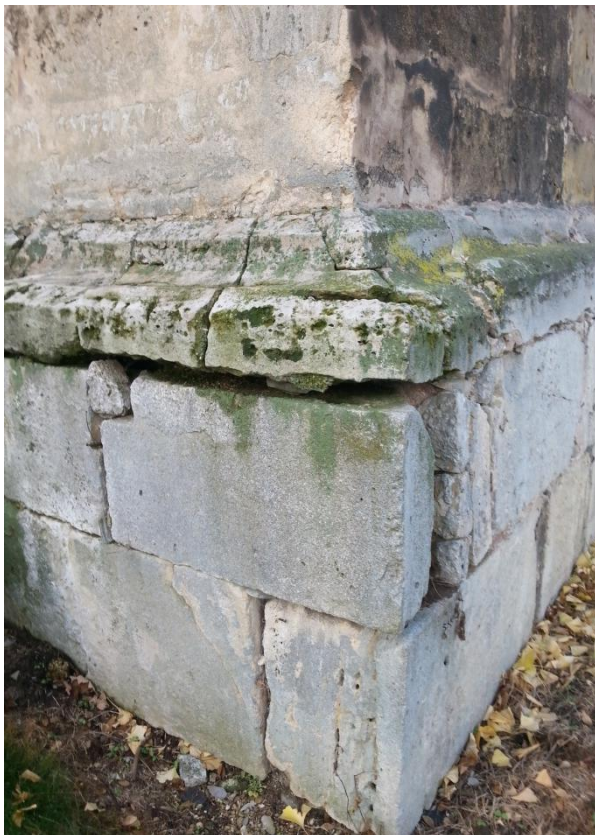
Abb. 13: Bausubstanz Turm, von Südost
