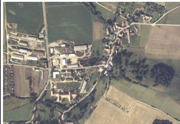
Abb. 46: Kirchremda (Saalfeld-Rudolstadt): Zerstört durch Abriss, Gewerleneubau
