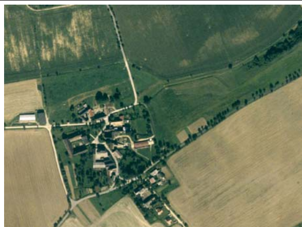
Abb.35: Grabsdorf (Saale-Holzland-Kreis): Rundweiler – Teilerhalten durch Abriss
