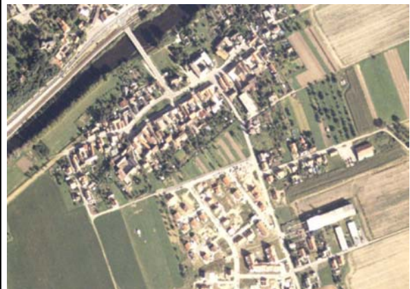
Abb.110: Oelknitz (SHK): Zeilendorf – Zerstört, Abriss und massive Erweiterung
