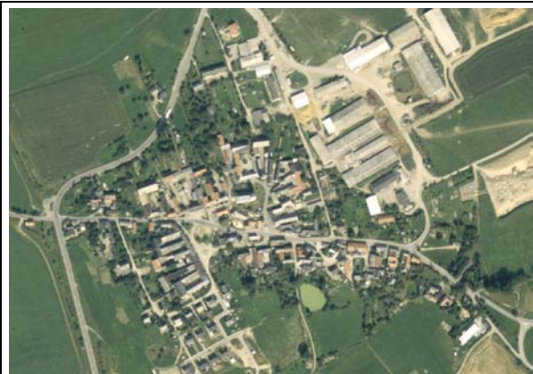
Abb.60: Tegau (Saale-Orla-Kreis): zerstörte Initialform durch Abriß und Dorferweiterung
